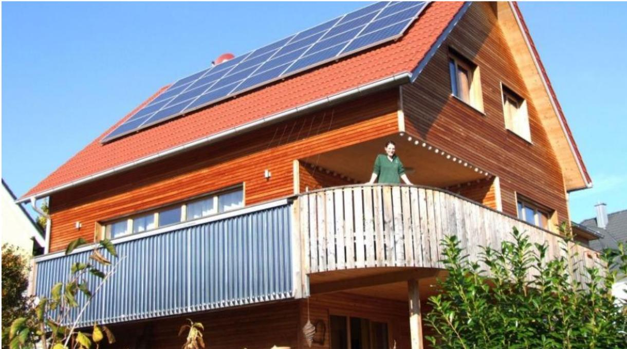
Dieses Holzbauhaus in Langenneufnach verbindet Solarthermie und Photovoltaik. Erstere ist dort in der Balkonbrüstung integriert.
