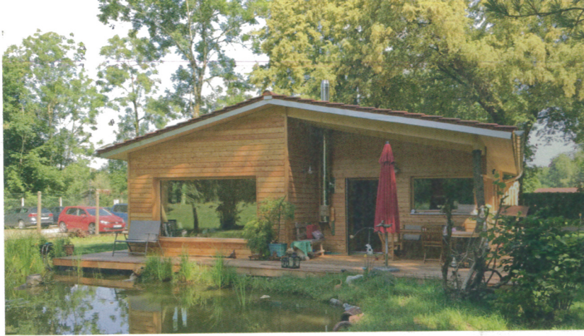
Das fertig gestellte Austragshaus auf dem Gelände des Marienbad-Hotels in Bad Wörishofen Fotos: Staudenschreiner
