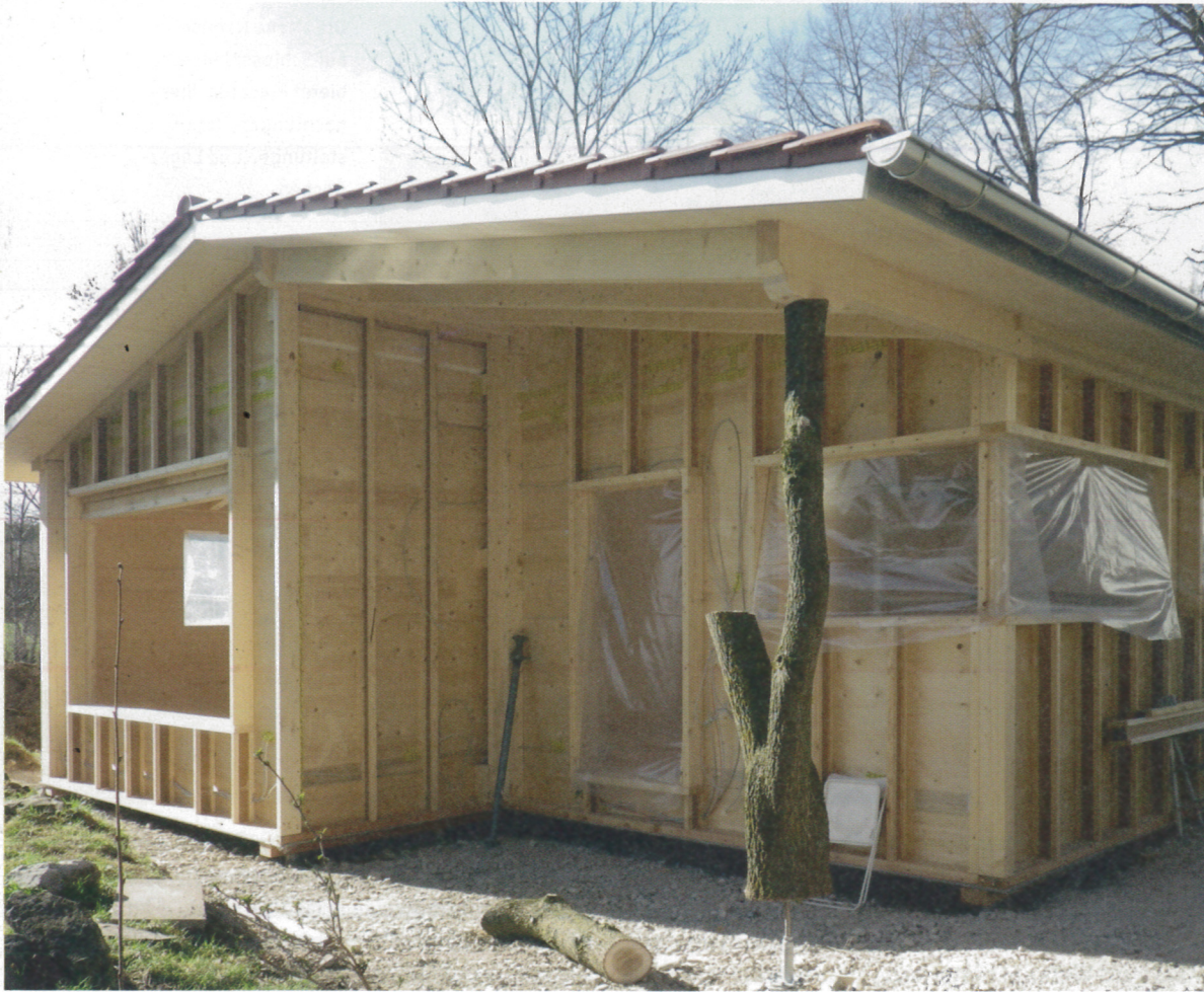
Der Rohbau steht nach wenigen Tagen
