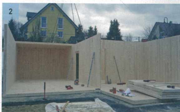
1 Die ersten Innenwände werden gesetzt
