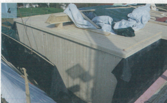
3 Mit einem Kontaktsprühkleber sprühen die Handwerker sowohl Plane als auch Holz ein und verkleben es dann. Die Überlappungen an den Ecken werden verklebt und zusätzlich verschweißt
