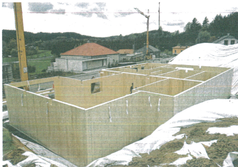
Fast im Handumdrehen: Der Holzkeller steht innerhalb nur eines Tages und ist sofort beziehbar. Foto: Rüdiger Sinn
